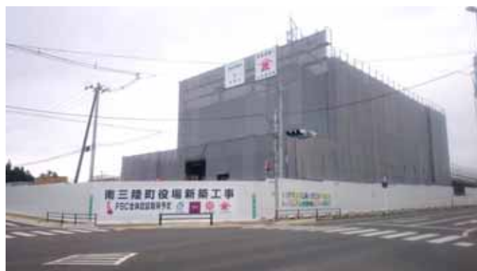
南三陸町役場の庁舎建設も進んでいました。
